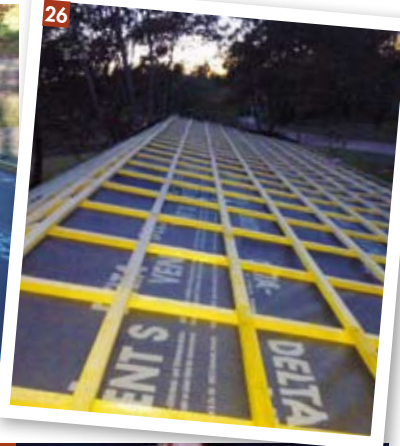
24 à 26 - La charpente est prête à être isolée. La sous couverture et les avants-toits en volige, destinés à supporter les matériaux de couverture, sont mis en place.
