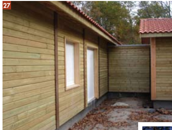
27 - Le propriétaire a choisi d'assurer l'intégralité du second œuvre. Les travaux ont commencé par la mise en place des menuiseries : la maison est désormais hors d'air. Des volets blancs ont été choisis, contrepoin moderne à l'esthétique naturelle de la maison, souhaitée par les propriétaires.
