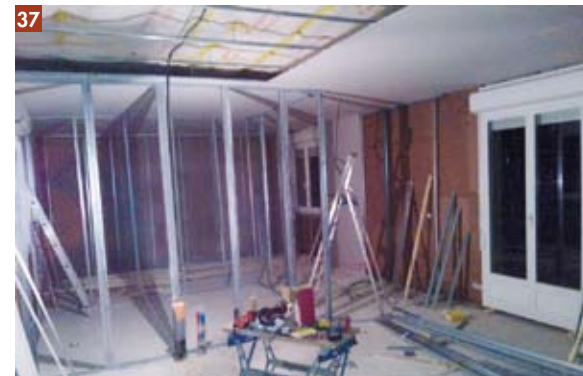
37 & 39 - Le chantier se termine à l'intérieur du bâtiment avec la mise en place des habillages et des cloisons, vissées sur des structures métalliques. Au préalable, les réseaux sanitaires et électriques ont été installés.
