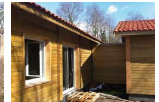
18 & 19 - Les propriétaires ont souhaité aménager leur maison en deux pôles distincts. Une préférence rendue possible par ce mode constructif puisque plusieurs modules de surfaces différentes peuvent être reliés par un sas de liaison. Ici, cet espace de 6m 2 permettra la libre circulation entre la pièce à vivre et l'espace nuit. Il sera aussi un lieu de rangement, puisque deux dressings seront installés.
