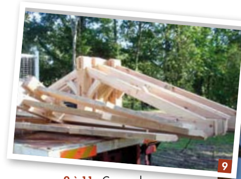
9 à 11 - Comme les panneaux, les fermes ont déjà fait l'objet d'un premier montage en atelier, pour un gain de temps. La structure en poteaux poutres est assemblée au fur et à mesure avec les panneaux, de même que la charpente traditionnelle chevillée. Le dernier panneau est enfilé par le haut, entre les poteaux.
