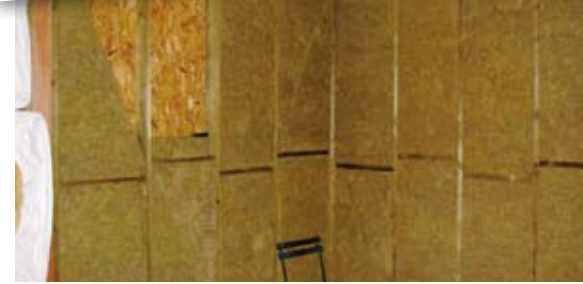
35 & 36 - L'association de la laine de verre et de la fibre de bois permet de compenser la faible densité du mur en bois. Elle assure également un meilleur confort d'été et une isolation acoustique performante. Là aussi, un pare vapeur est mis en place.
