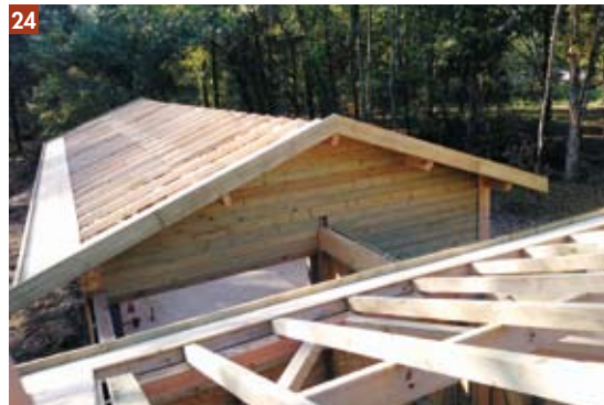
24 à 26 - La charpente est prête à être isolée. La sous couverture et les avants-toits en volige, destinés à supporter les matériaux de couverture, sont mis en place.
