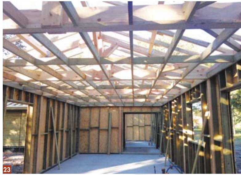
22 & 23 - La charpente traditionnelle chevillée est achevée. Dans ce bâtiment, la charpente est laissée apparente, tandis que le second bâtiment est équipé d'un plafond suspendu. Dans ce type de chantier, les deux possibilités existent.
