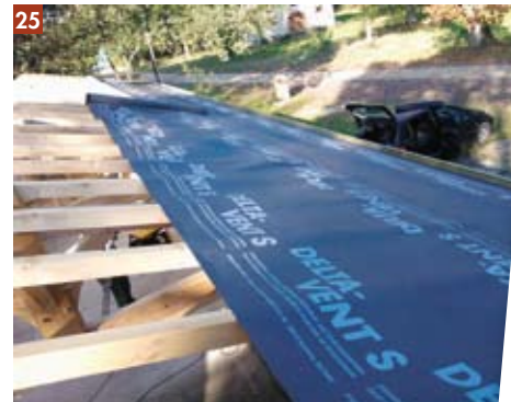
24 à 26 - La charpente est prête à être isolée. La sous couverture et les avants-toits en volige, destinés à supporter les matériaux de couverture, sont mis en place.
