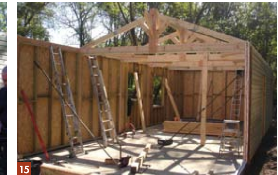
14 à 16 - Tous les éléments sont entaillés, de façon à garantir un assemblage rapide, propre et précis. Le montage de la charpente vient consolider l'ensemble de la construction, tout au long du montage.
