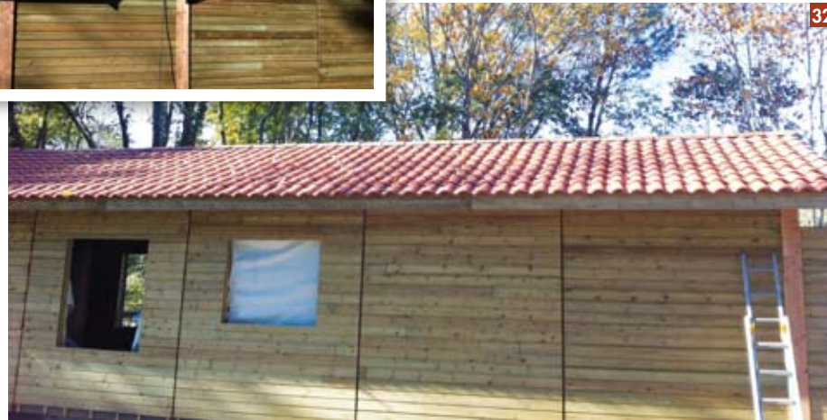
31 & 32 - Pour la couverture de toit, les propriétaires ont opté pour des tuiles classiques. La pose a été faite en un peu plus d'une journée. La couleur chaude des tuiles se marie parfaitement à l'environnement boisé. La maison est alors hors d'eau hors d'air.
