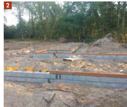
2 & 3 - Après avoir monté les rangs de parpaings, le maçon a coulé la dalle selon les plans indiqués par le constructeur. Sableux et plat, le sol ne posait aucun problème particulier. C'est donc une chape de béton traditionnelle qui a été adoptée.
