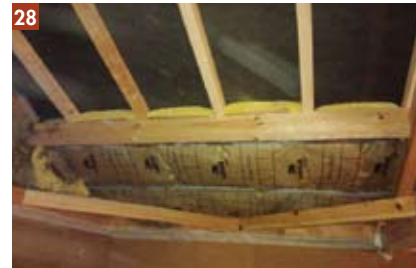
28 & 29 - L'isolation est une étape importante du chantier, car il est essentiel d'éviter les ponts thermiques occasionnant des pertes de chaleur. Dans cette maison construite avant l'application de la RT 2012, les plafonds ont été isolés avec de la laine de verre puis un pare vapeur, tendu et scotché pour garantir l'étanchéité.
