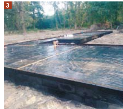
2 & 3 - Après avoir monté les rangs de parpaings, le maçon a coulé la dalle selon les plans indiqués par le constructeur. Sableux et plat, le sol ne posait aucun problème particulier. C'est donc une chape de béton traditionnelle qui a été adoptée.
