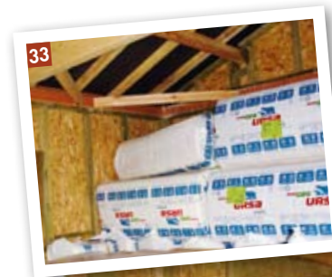
33 & 34 - Pour isoler les murs, la laine de verre en 120 mm a été choisie. Des panneaux de fibres de bois en 40 mm seront ensuite placés en couche croisée.
