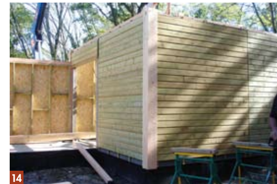
14 à 16 - Tous les éléments sont entaillés, de façon à garantir un assemblage rapide, propre et précis. Le montage de la charpente vient consolider l'ensemble de la construction, tout au long du montage.
