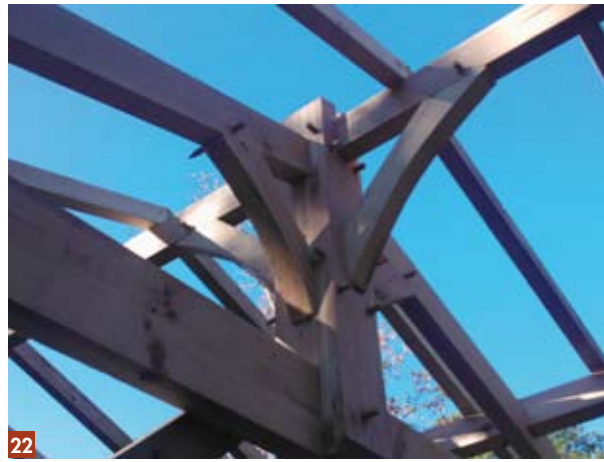
22 & 23 - La charpente traditionnelle chevillée est achevée. Dans ce bâtiment, la charpente est laissée apparente, tandis que le second bâtiment est équipé d'un plafond suspendu. Dans ce type de chantier, les deux possibilités existent.
