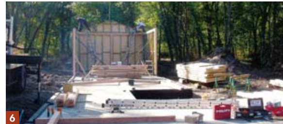
5 à 8 - Le kit de la maison est livré sur le chantier, par l'entreprise de construction. Les panneaux modulaires en bois ont été préalablement bardés en atelier afin de gagner du temps lors du montage.
