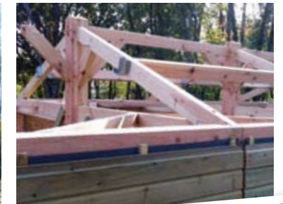
12 & 13 - Les panneaux sont en pin sylvestre naturel, une essence de bois fréquemment utilisée dans la construction en raison de sa solidité.
