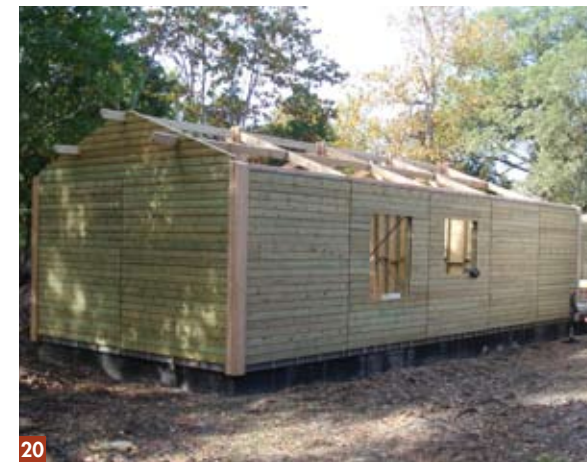
20 & 21 - En quelques heures, les contours de la maison se dessinent précisément. Une rapidité permise par la construction bois en générale, et plus particulièrement par le système des panneaux modulaires. Seulement quatre jours ont été nécessaires à l'élévation des murs, de la charpente et du chevronnage.
