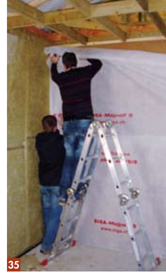
35 & 36 - L'association de la laine de verre et de la fibre de bois permet de compenser la faible densité du mur en bois. Elle assure également un meilleur confort d'été et une isolation acoustique performante. Là aussi, un pare vapeur est mis en place.
