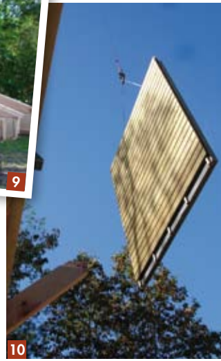
9 à 11 - Comme les panneaux, les fermes ont déjà fait l'objet d'un premier montage en atelier, pour un gain de temps. La structure en poteaux poutres est assemblée au fur et à mesure avec les panneaux, de même que la charpente traditionnelle chevillée. Le dernier panneau est enfilé par le haut, entre les poteaux.
