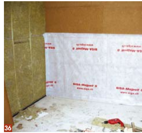
35 & 36 - L'association de la laine de verre et de la fibre de bois permet de compenser la faible densité du mur en bois. Elle assure également un meilleur confort d'été et une isolation acoustique performante. Là aussi, un pare vapeur est mis en place.
